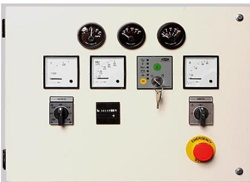
Альтернативная система управления для этой модели - **BC 701** (фото), построена на модуле управления с помощью ключа DSE 701. Это обеспечивает ручной контроль ДГУ посредством 2-х позиционного ключа переключения режимов и мембранный кнопки для запуска, наряду с защитой от превышения частоты вращения двигателя, понижения давления масла и перегрева охлаждающей жидкости.
